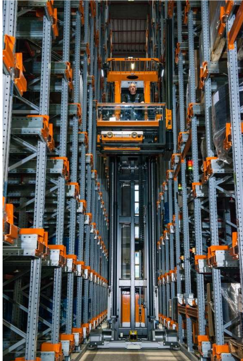
Bild 2 : Shuttle-Hochregallager (18 Meter) mit 10.650 Paletten Stellplätzen
