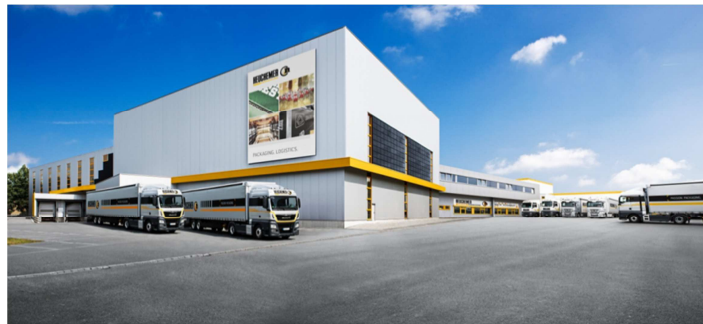
Bild 1 : 2013 entstandenes Logistikzentrum der Heuchemer Verpackung am Standort Miehlen
