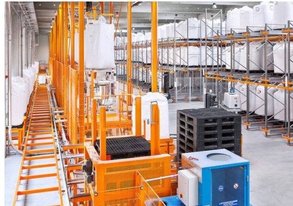
Perfekt funktioniert das Zusammenspiel der Fördertechnik mit dem Verschiebewagen und dem Stapelautomaten für die Leerpaletten.
